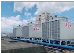
▲ 辦公大樓冷卻水塔更新
