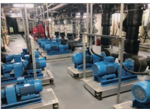
▲ 設置高效水泵
